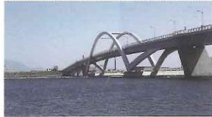
海の中道大橋(福岡市東区)
